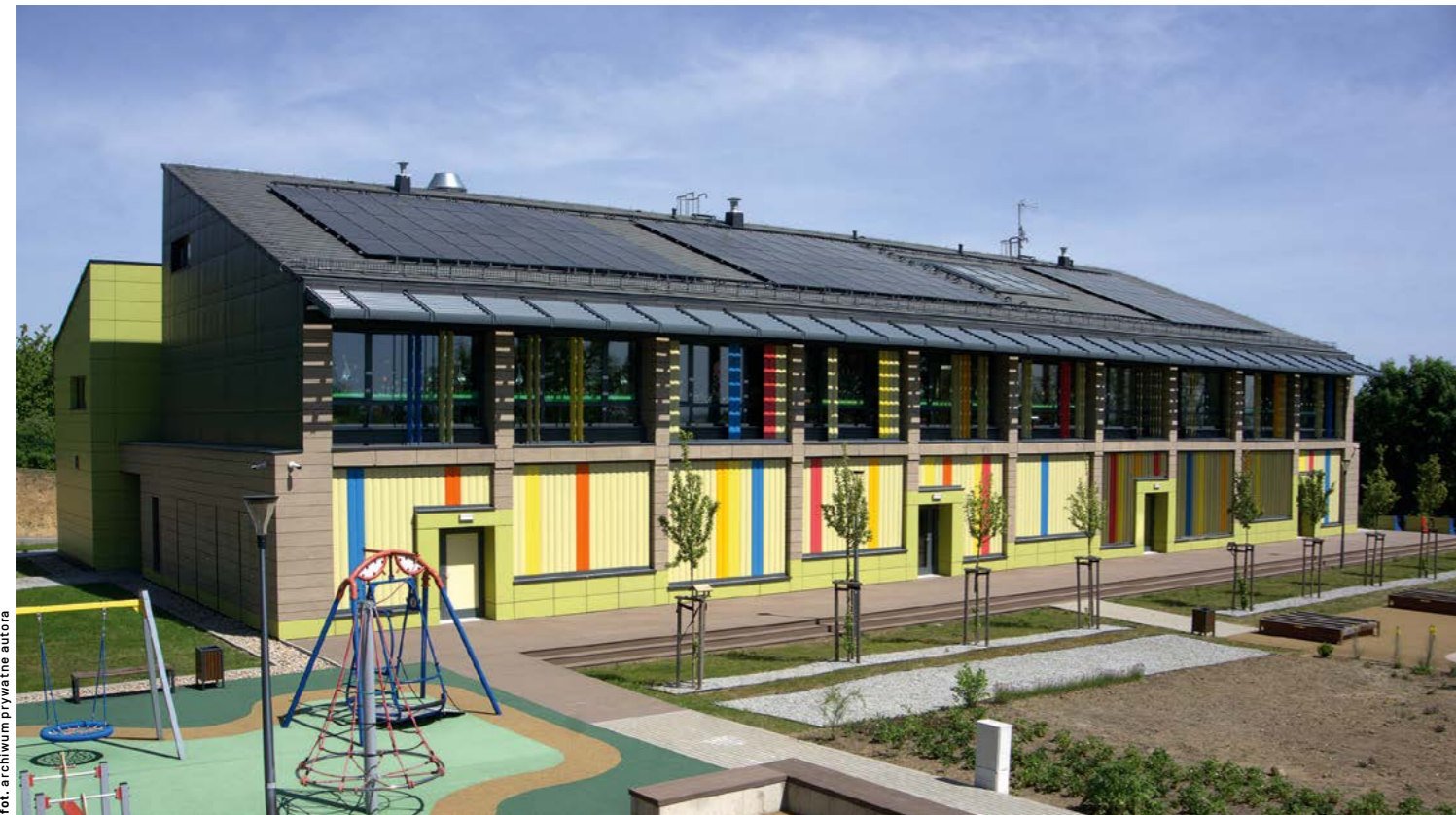
Plusenergetyczne przedszkole i żłobek w Strzegomiu, proj. ARCHIMMODICUS: architekci Grażyna Hryncewicz-Lamber, Katarzyna Sierka-Szczucka, Przemysław Nowakowski (koncepcja).
